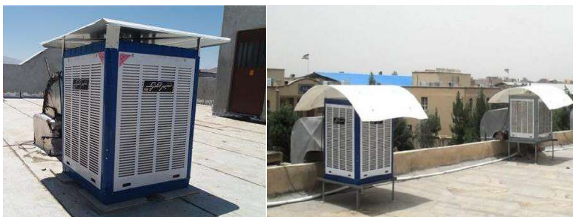
شکل ۳۰: نصب سایبان بر روی کولرهای آبی
