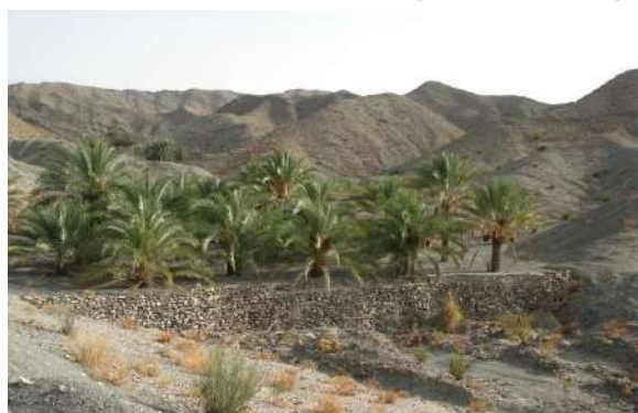
نمونه ای از احداث بند سنگی برای جمع آوری آب باران برای آبیاری نخلستان در هرمزگان
