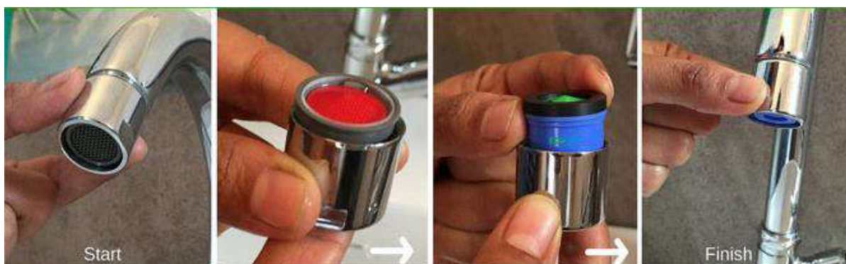
شکل ۲۴: نحوه تعویض یا نصب سرشیر
