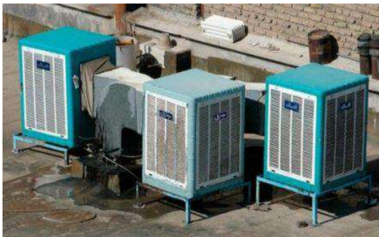
شکل ۲۹: چکه کردن و یا سرریز آب از کولرهای آبی در فصول گرم سال
